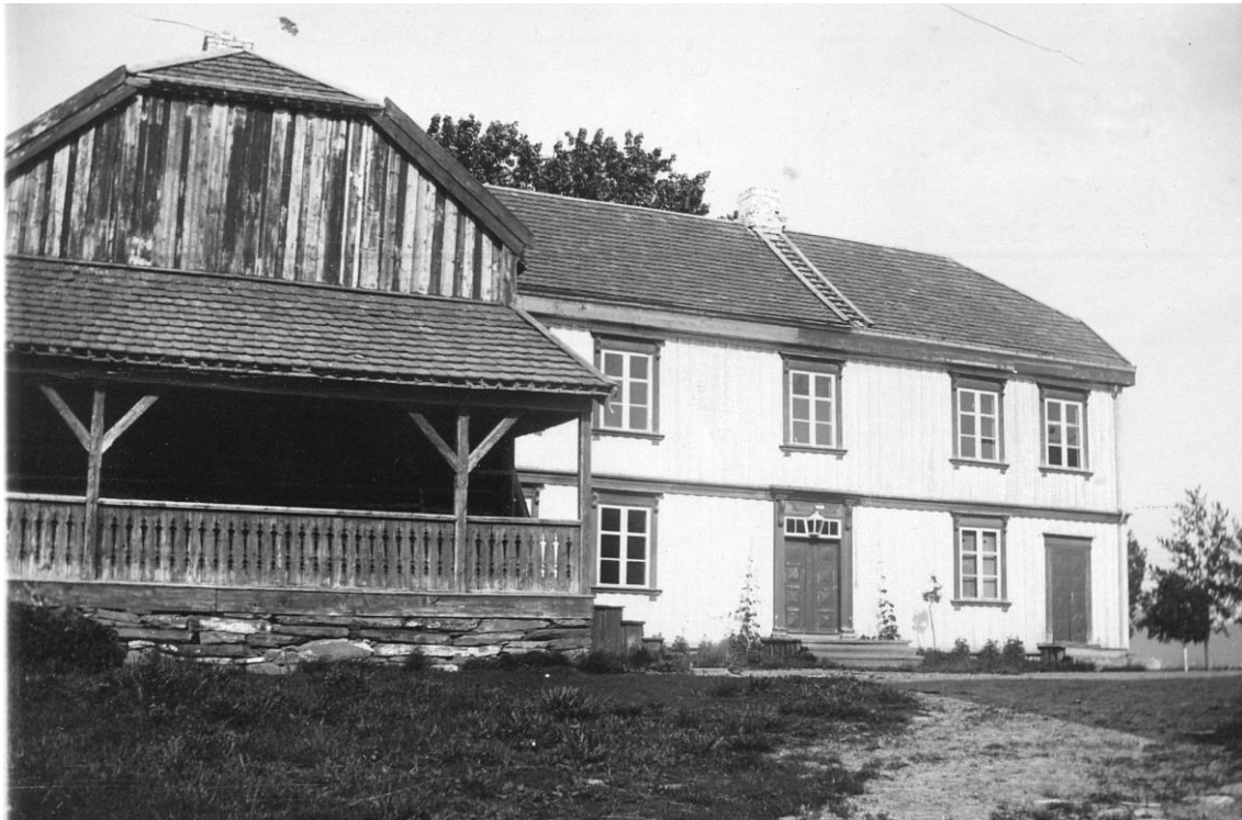
Medbroen før 1885 med den gamle hovedbygningen i forgrunnen. Døra helt til høyre i bildet førte inn til Landhandelen
