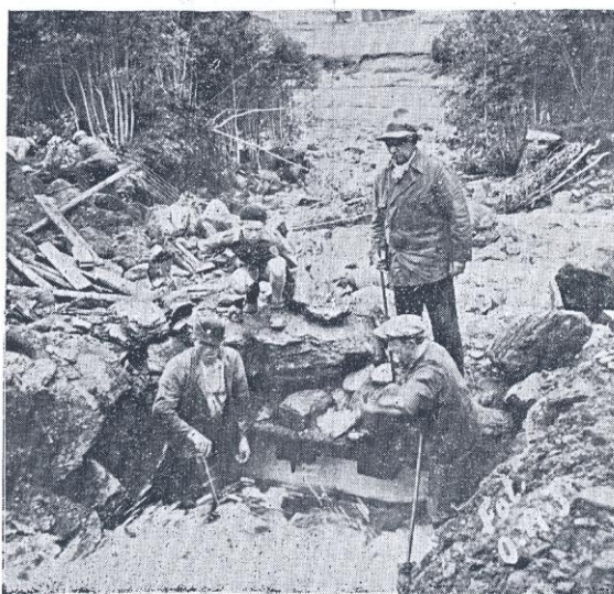
Det samme bruddsted. Her ses jernbanelinjen under steinmassene. Flere steinblokker måtte sprenges i stykker for å bli fjernet.
