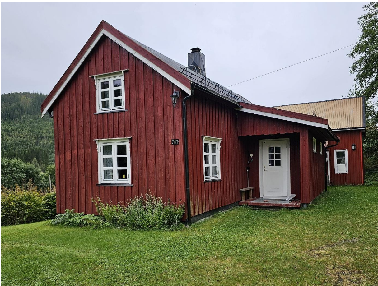
Huset fra Rauåkløfta, slik det står på Dalberg i 2025
