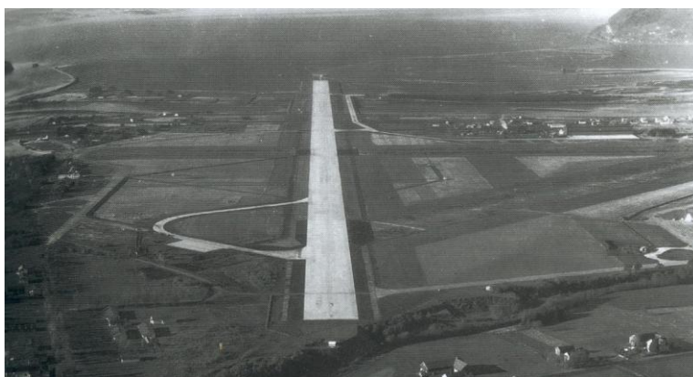
Ny rullebane - ferdig forlenget 1961 (foto: B. Gimnes)
