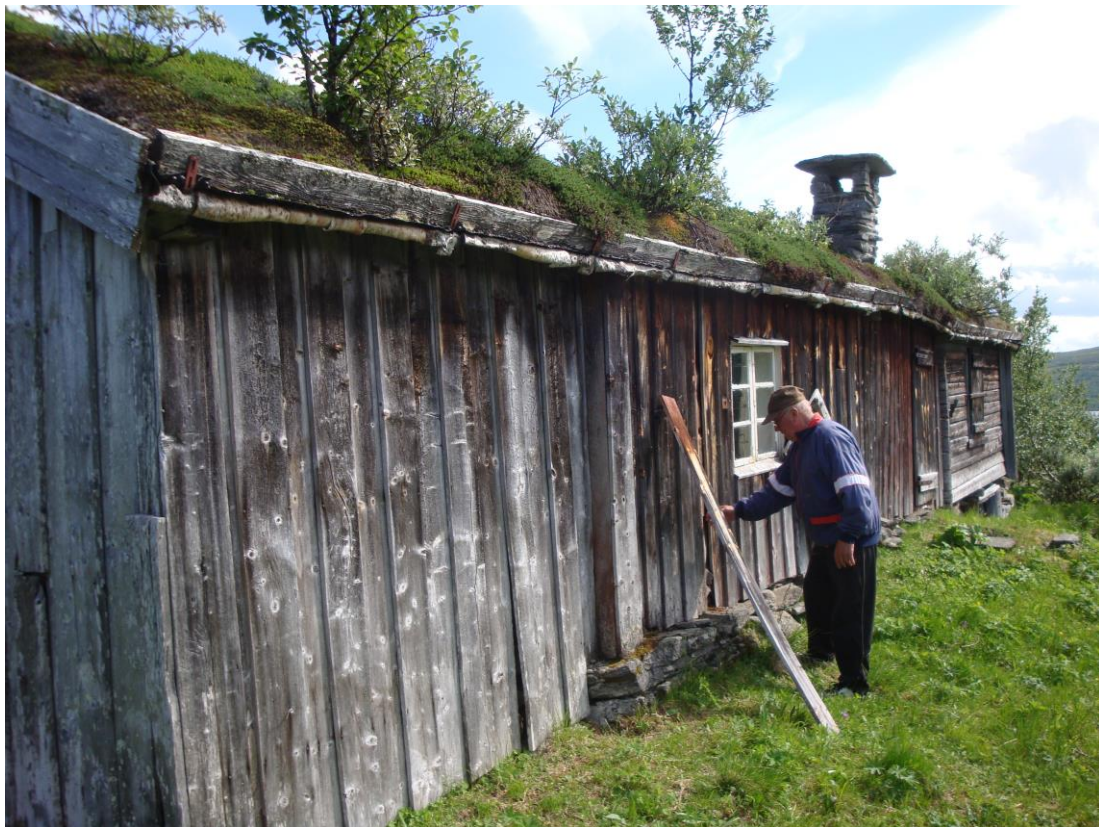
Som pensjonist begynte Jon Reidar Holte med et stort restaureringsarbeid på både sin seter og hytte på Riasten. (Foto/copyright: Liv S. Holte)
