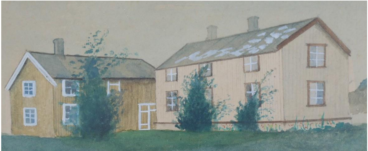
Eiendommen ved Thyholtvegen slik den var frem til 1999
