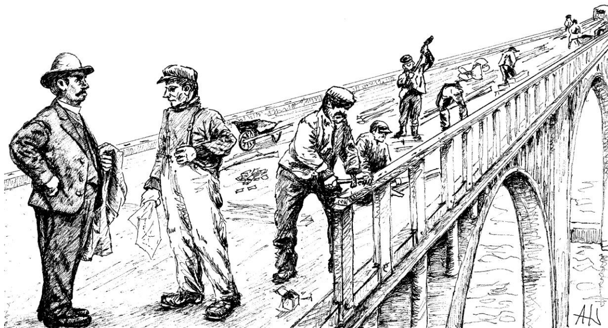
Ingeniøren Grytbak inspiserer byggingen av broen
