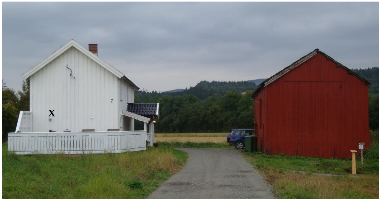
Nytrøen på Prestmoen 17. september 2016 X: bombesplinten gikk inn gjennom vegg. Ned til høyre i bildet står minneplaten
