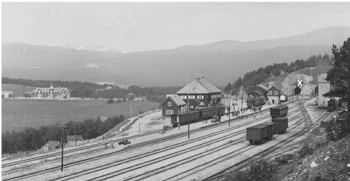
Dombås stasjon i 1940, x: relaterte tunnel (foto: Anders Beer Wilse)
